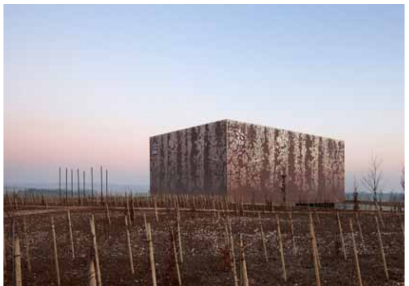
LAN Architecture, Centro archivi EDF, Bure, Francia, 2011
