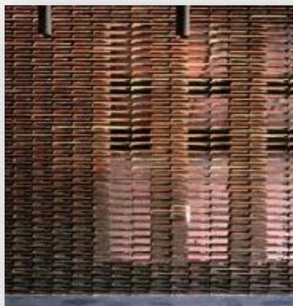
L'assenza di alcuni elementi di giuntura genera un diaframma verticale permeabile al passaggio della luce.
